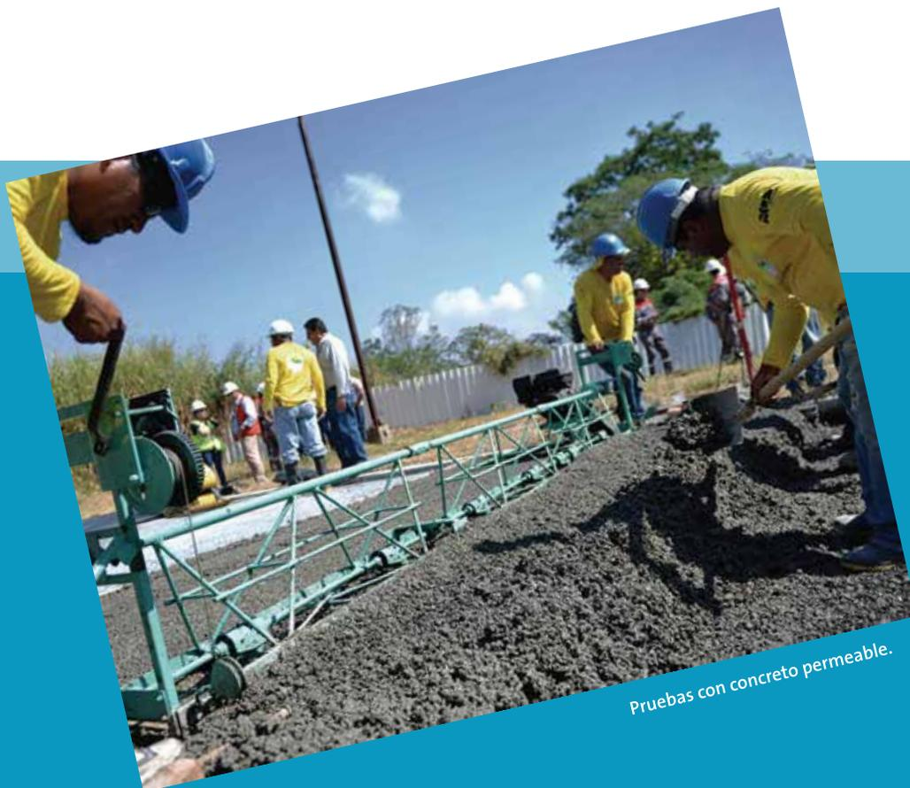
Pruebas con concreto permeable.
